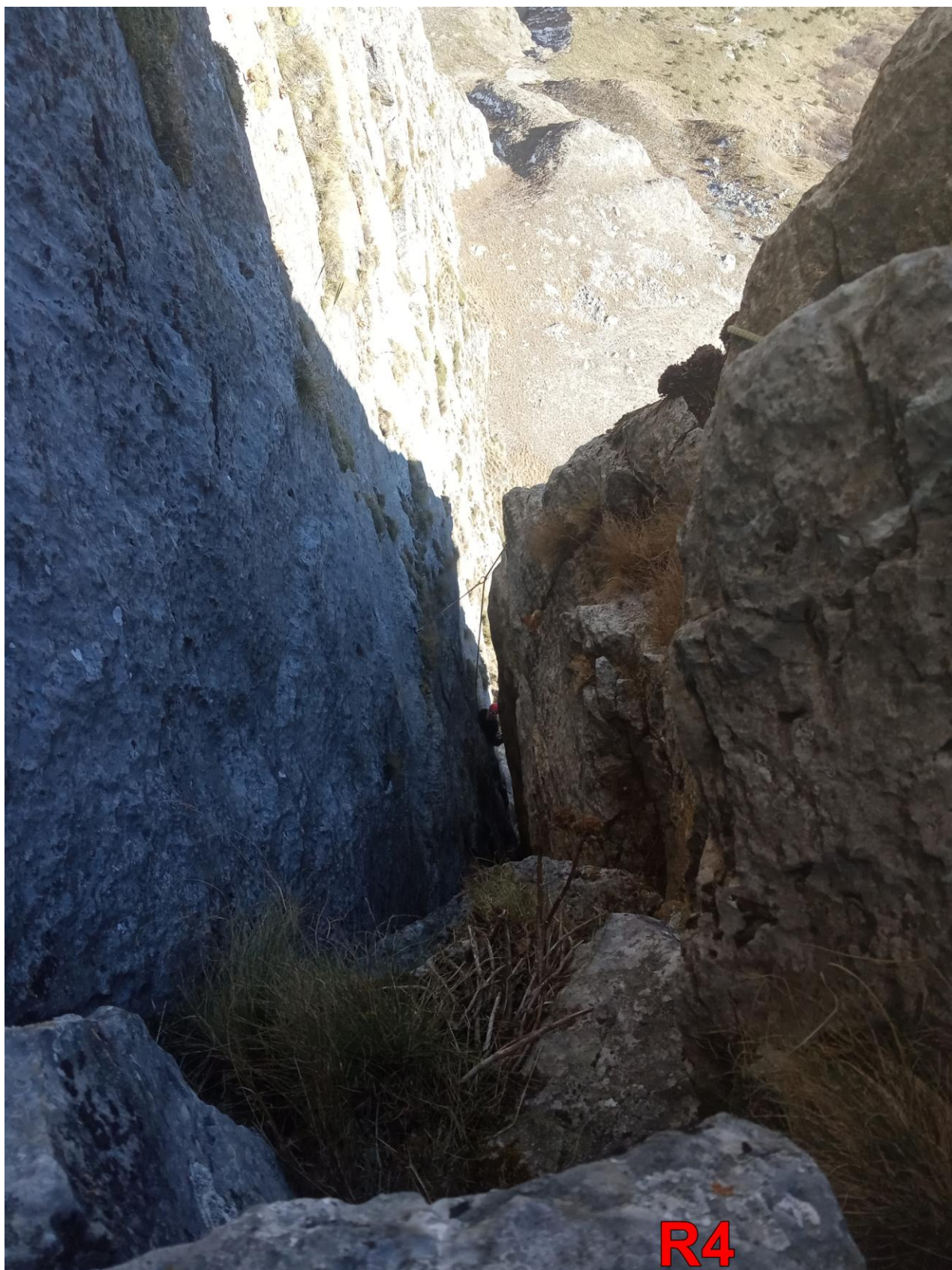
Камин на участке R3-R4, вид сверху.
