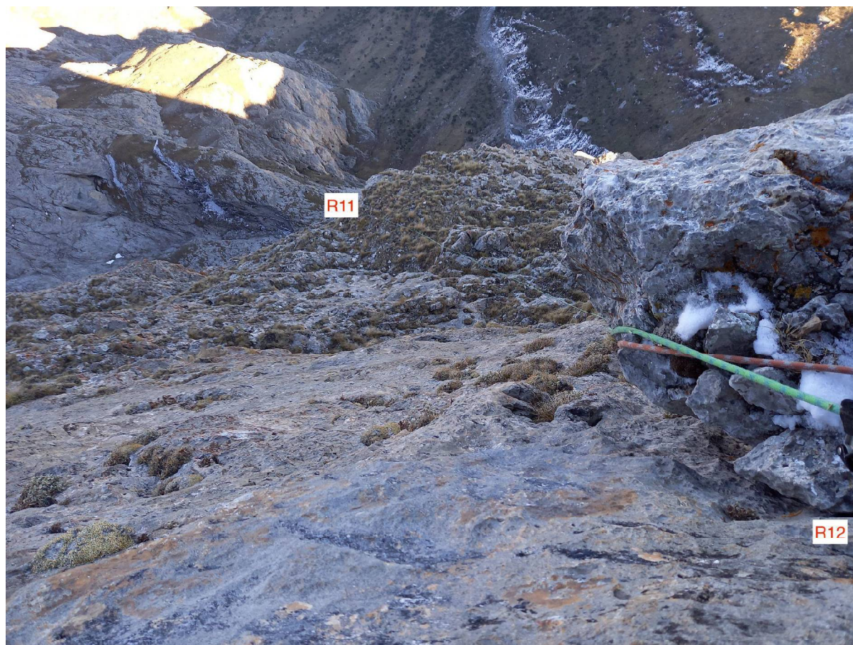
R11-R12, вид со станции R12
