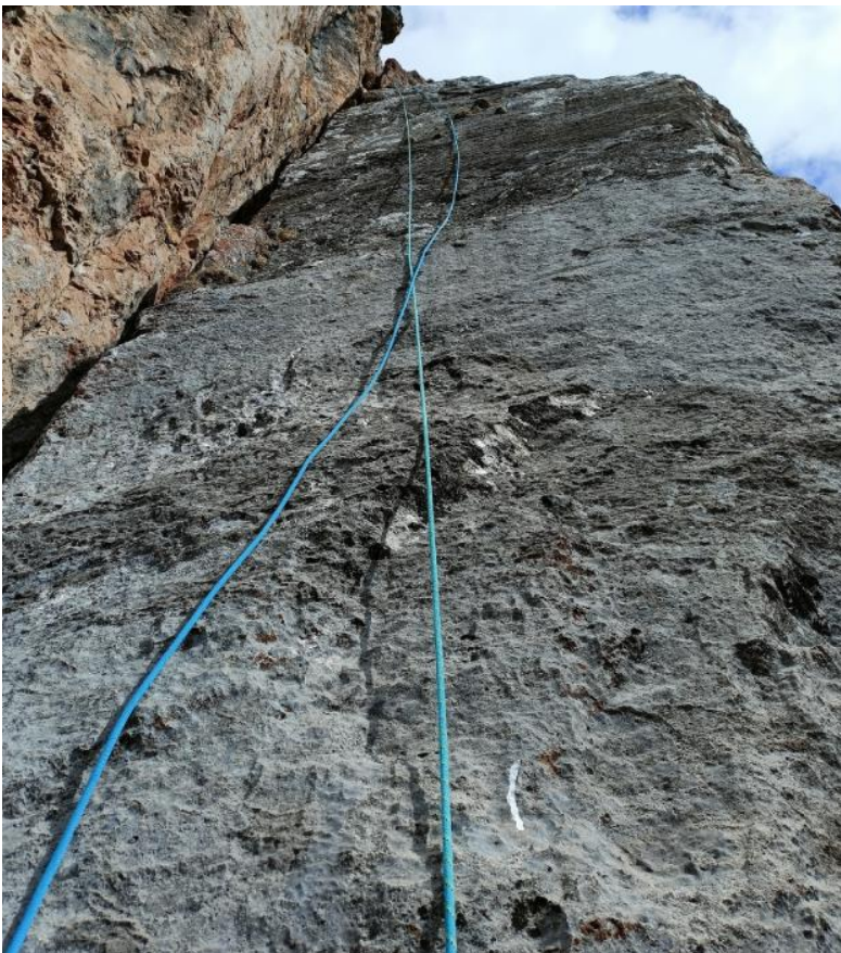
Плита на участке R10-R11.
