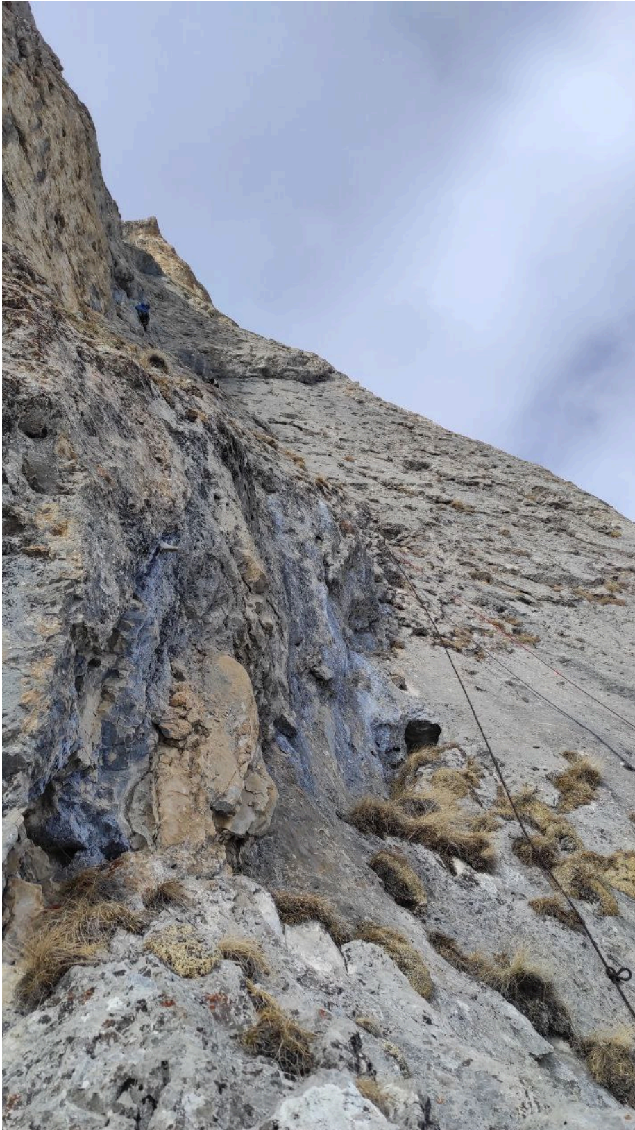
Рисунок 14 Фото – работа 16.02.2024 на участке R9 – R10
