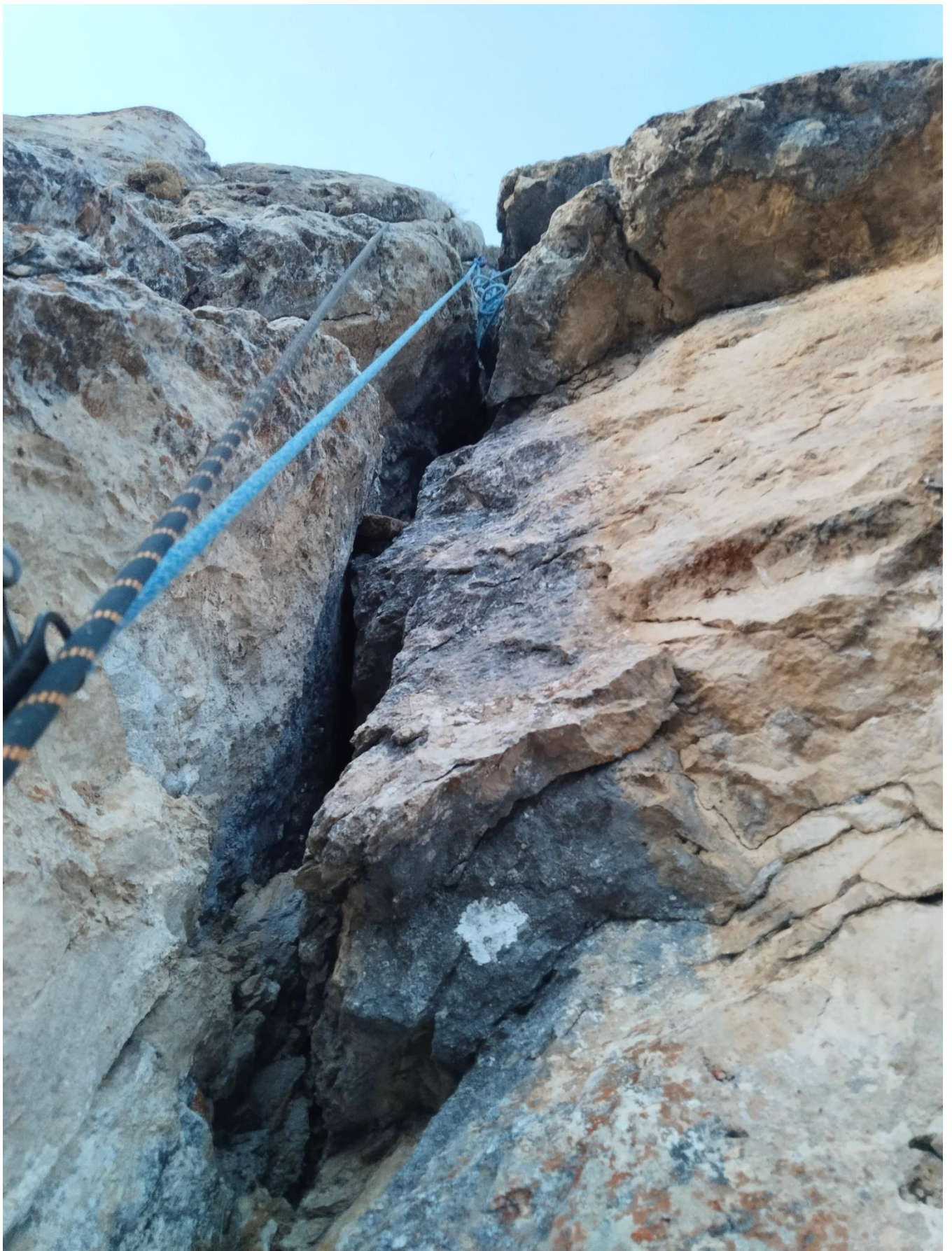
Фото №14. Участок R14-R15. Нависание после внутреннего угла.
