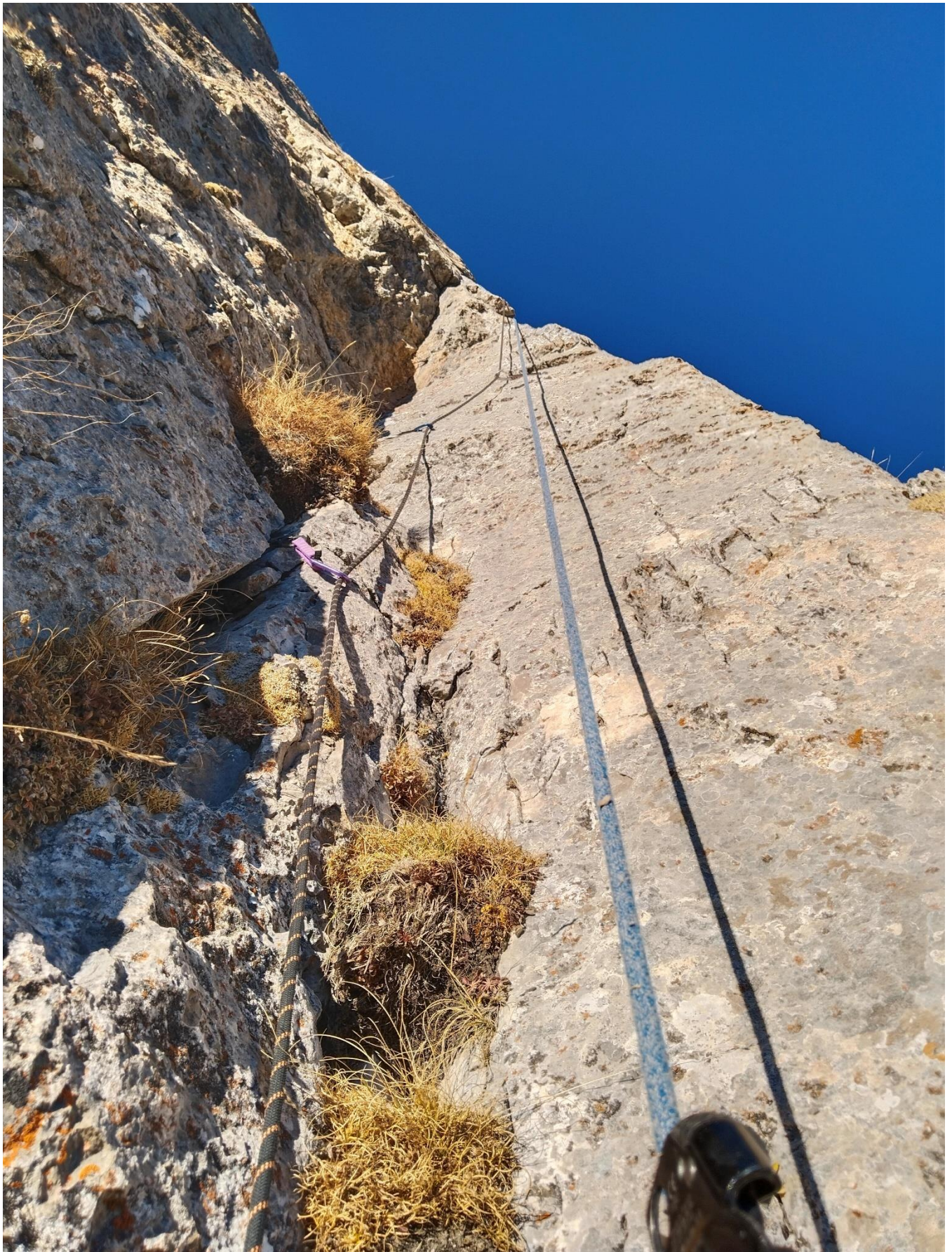
Фото №13. Внутренний угол после стенки ИТО на участке R13-R14.
