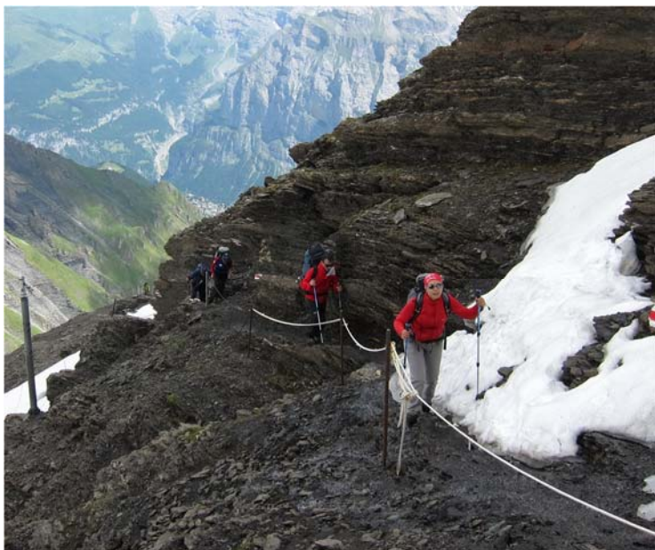
Ограждения из стоек и толстого синтетического троса, Швейцария, Альпы
