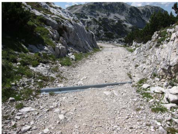
Система дренажа троп и дорожек в районе массива Дахштейн, Альпы
