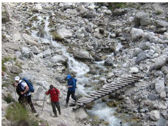
Пример простейшей конструкции моста из бревен. Установлен в районе АУСБ «Безенги», КБР, РФ
