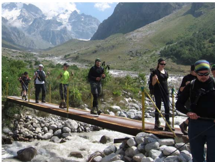
Пример жёсткой конструкции моста. Мост установлен в районе АУСБ «Безенги», КБР, РФ
